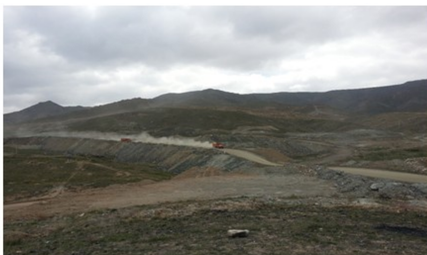
شکل 1: نمونه ای از تخریب دامنه های جنوبی مشهود به منظور احداث کنار گذر جنوبی
