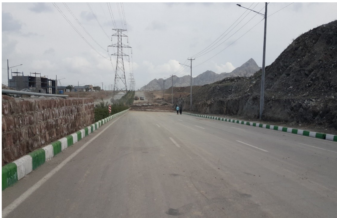
مجموعه شکل ۲۲- احداث بلوار بدون توجه به شیب زمین و عدم طراحی پل برای انتقال سیلاب که منجر به تخریب بلوار و بسته آن در سیل اخیر مشهد است (بزرگراه کمر بند سبز - هفت حوض )
