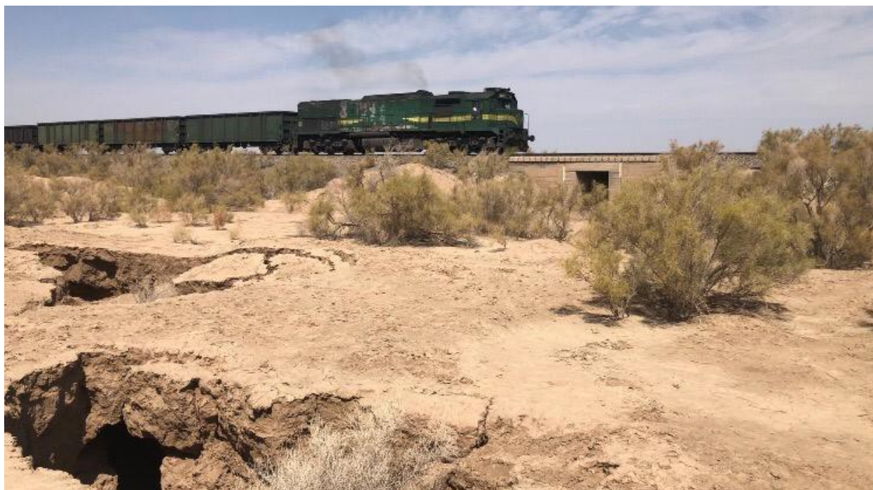
شکل ۷- فرونشست در چند متری خط راه آهن مشهد- تهران
