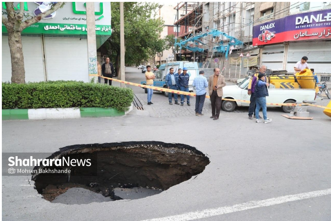
شکل ۶- فرونشست در خیابان کلاهدوز مشهد
