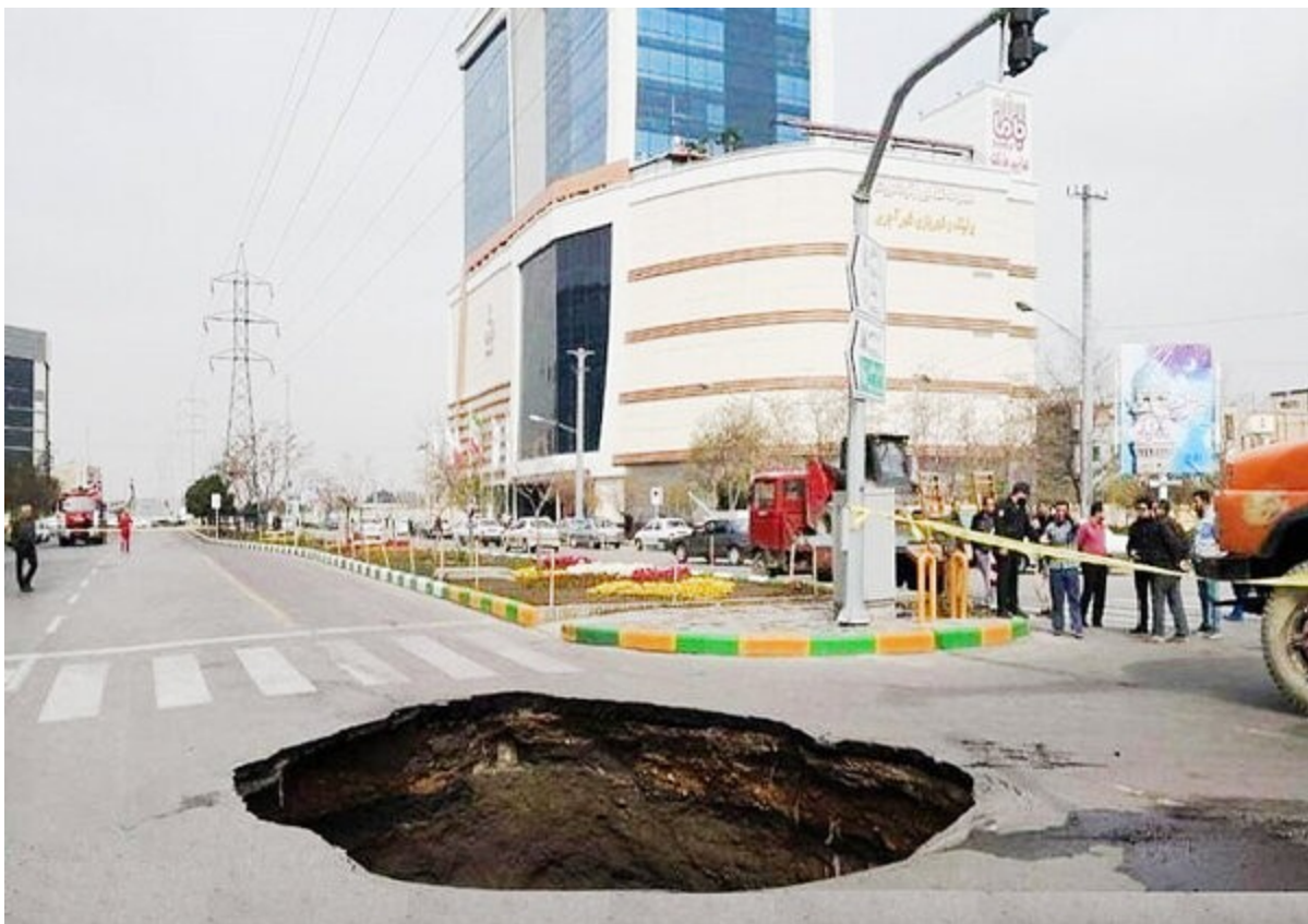
شکل ۱۱- فرونشست در چهارراه ساجدی مشهد
